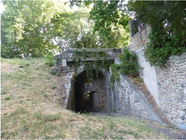
Pont en continuité de la rue du pont du curé, passant sous la RD 21, l'accès sous la route le proche du gîte (80 m). L'accès côté gîte est de la taille d'une porte.
