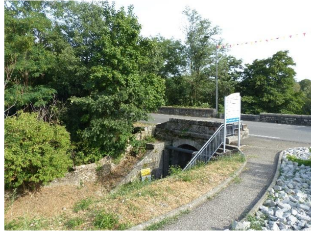
Pont de la rue longeant le parking de Beauchastel passant sous la RD21 à 220 m à l'ouest du gîte de la colonie.
