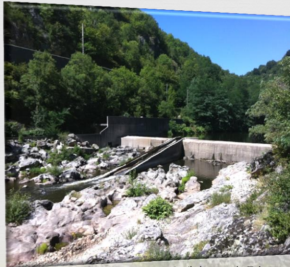
Seuil du pont de Talaron
