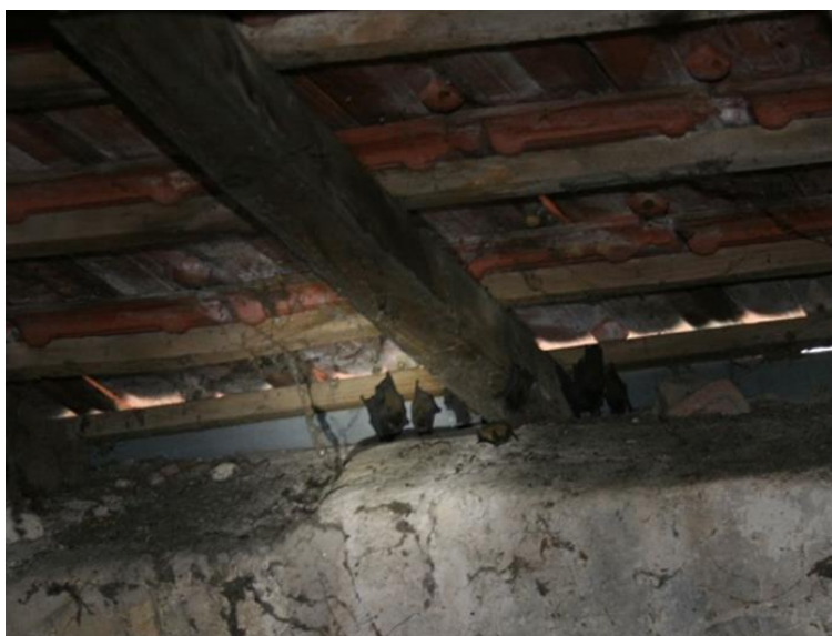
Colonie de parturition de pipistrelles dans une grange
