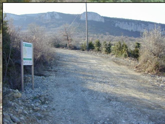
Réfection de piste
