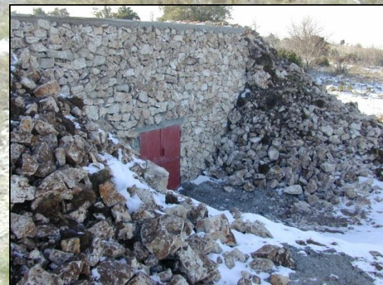
Construction d'une citerne de 50m3
