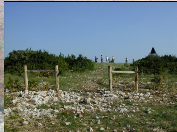
Création de 12 parcs avec clôtures électriques et barrières automatiques
