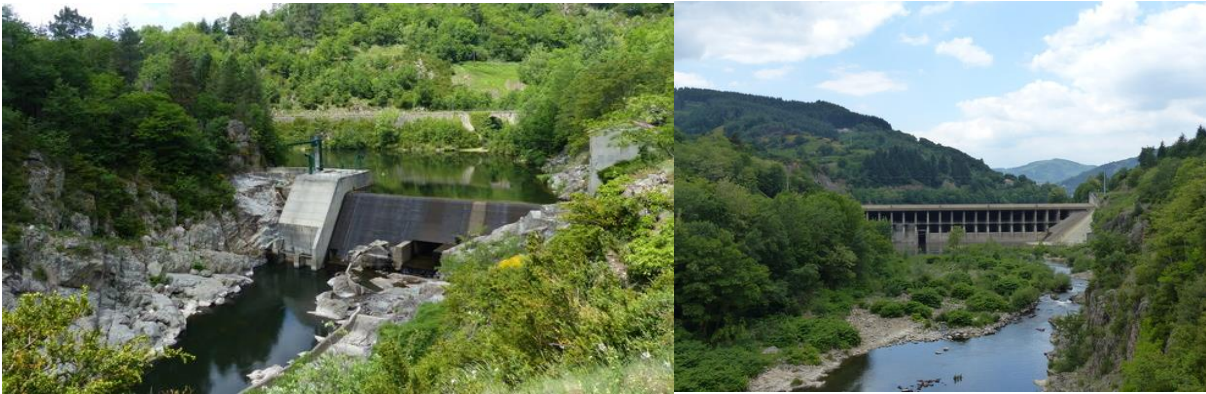
Illustration 5 : Barrage de Sarny (gauche) et barrage des Collanges (droite)
